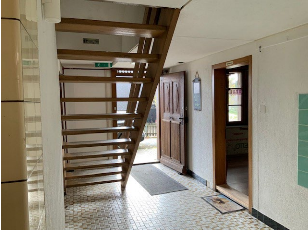
Treppe ins 1. OG beim Hauseingang
